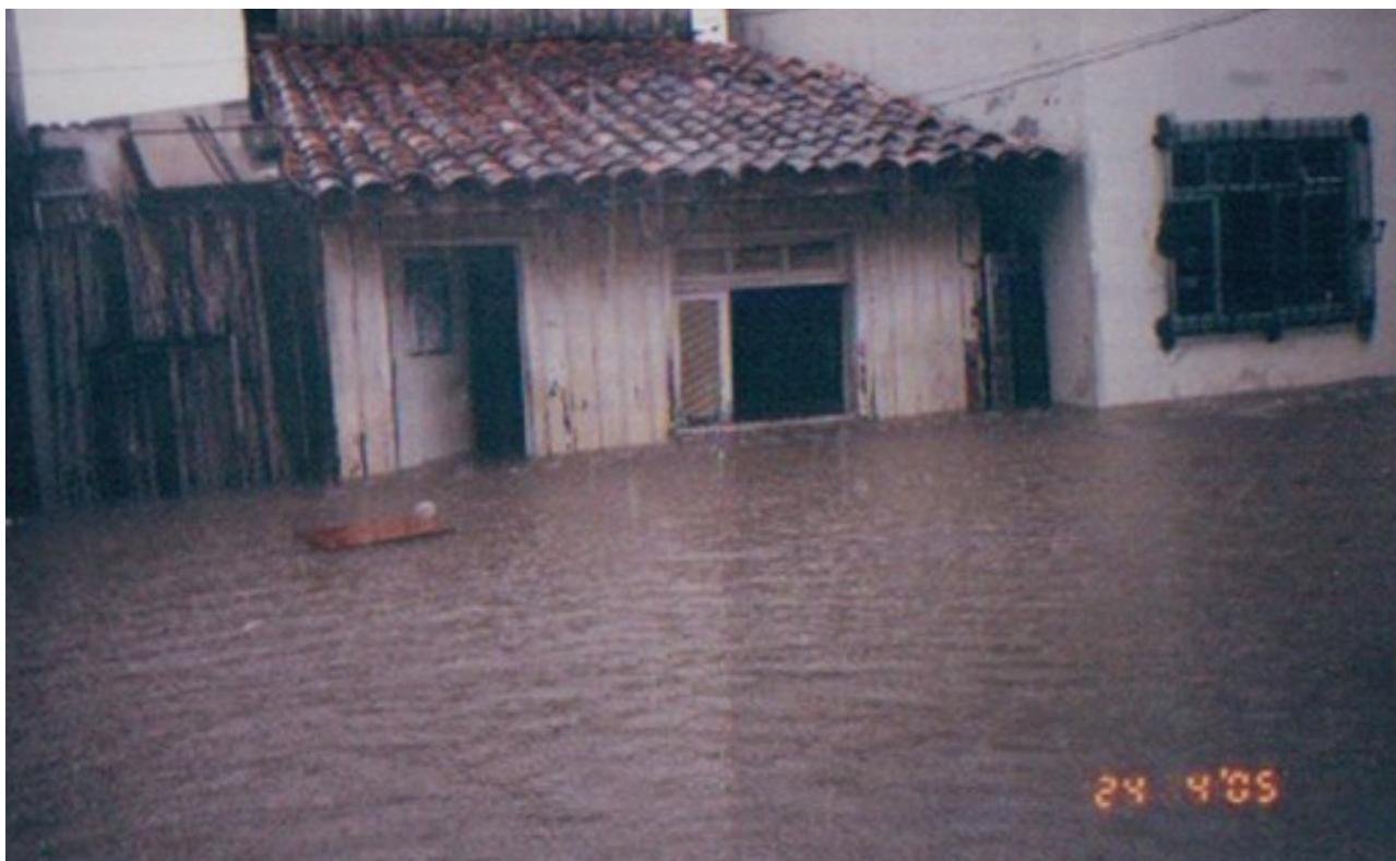
Imagem: Casa nº 5 da Vila Freitas, margem direita do Canal do Galo, próximo à Avenida Pedro Miranda, bairro da Pedreira. Ano de 2005. Foto: Acervo da FMPBU.
