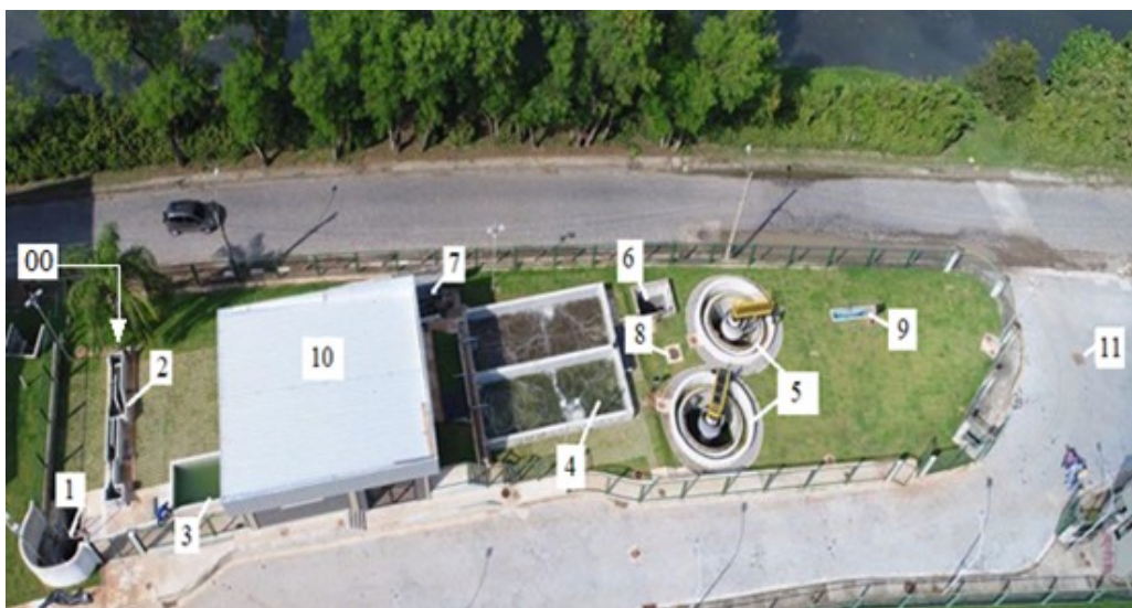
Foto 03: Tomada aérea da ETE-CTV
