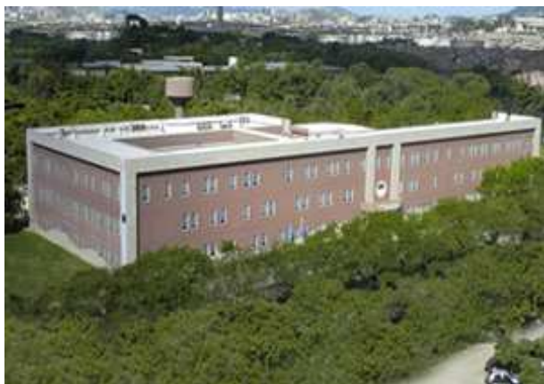
Reforma da Epsjv: prédio principal e biblioteca-auditório. Foto: COGIC
