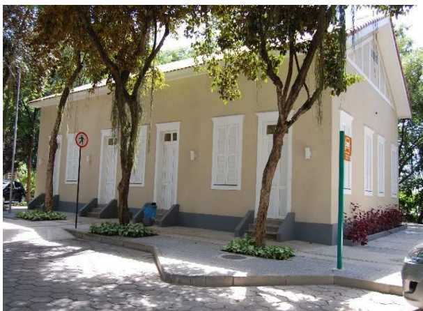
Reforma da casa administrativa, do INI. Foto: COGIC
